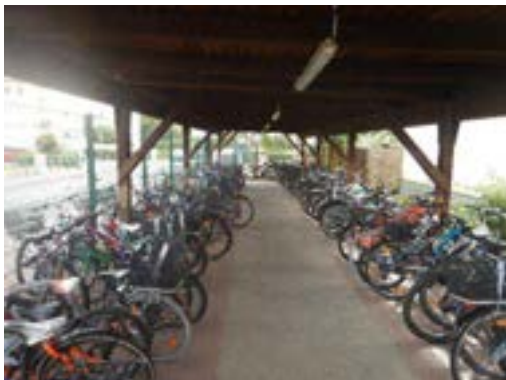
Abbildung 14: Abstellanlage mit Witterungsschutz
